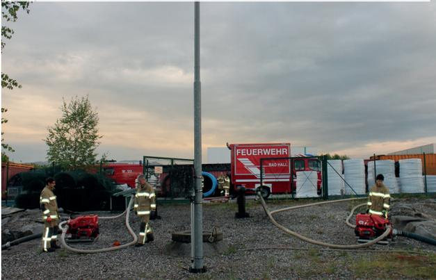
Übung und Kennenlernen: Wassereinspeisung aus Löschwasserbecken ins betriebseigene Hydrantennetz der Fa. Agru
